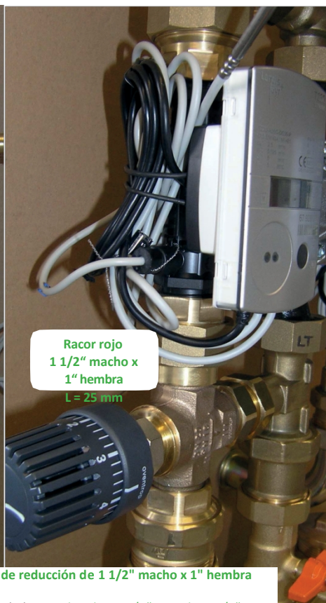
Situación de montaje con contador de calor ratiotherm
