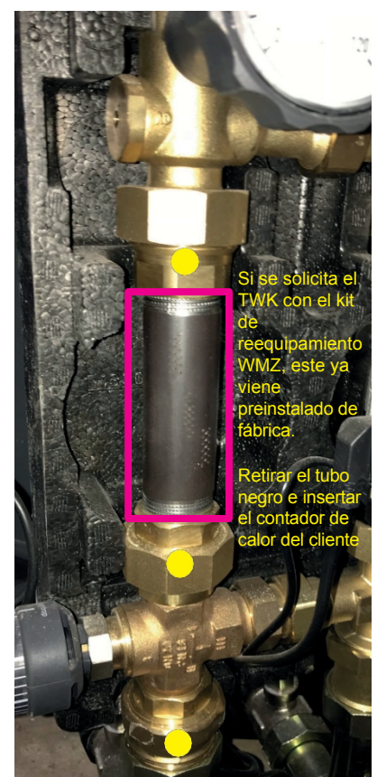
sin contador de calor ratiotherm
