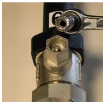
Retirer l'écrou de fixation
