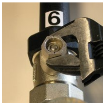
Robinet à boisseau sphérique Position ouverte Encoche (I)
