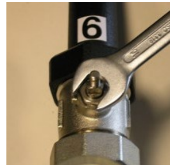
Prensaestopas Volver a apretar con una llave de horquilla
