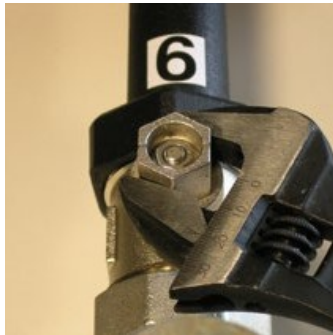
Válvula de bola Posición de cierre Muesca (-)
