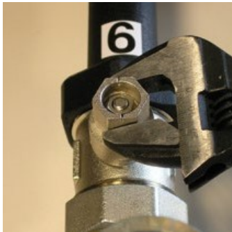
Válvula de bola Posición abierta Muesca (I)
