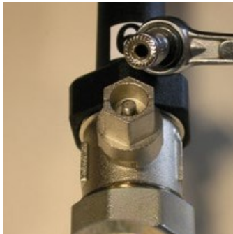
Retirar la tuerca de fijación
