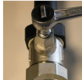
Tuerca interior Aflojar con llave de vaso
