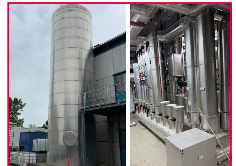
Neubau Nahwärmeversorgung Abwasserzweckverband Kempten Volumen: 120 m³
