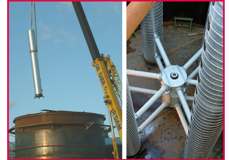
Gewächshauspeicher Holland, Volumen: 110 m³
