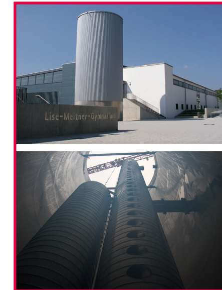
Solare Nahwärme Crailsheim Volumen: 100 m³
